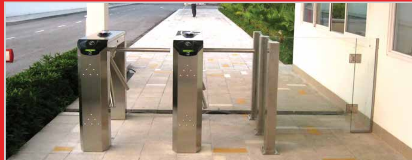
NHÀ MÁY VIỆT PHÁP
